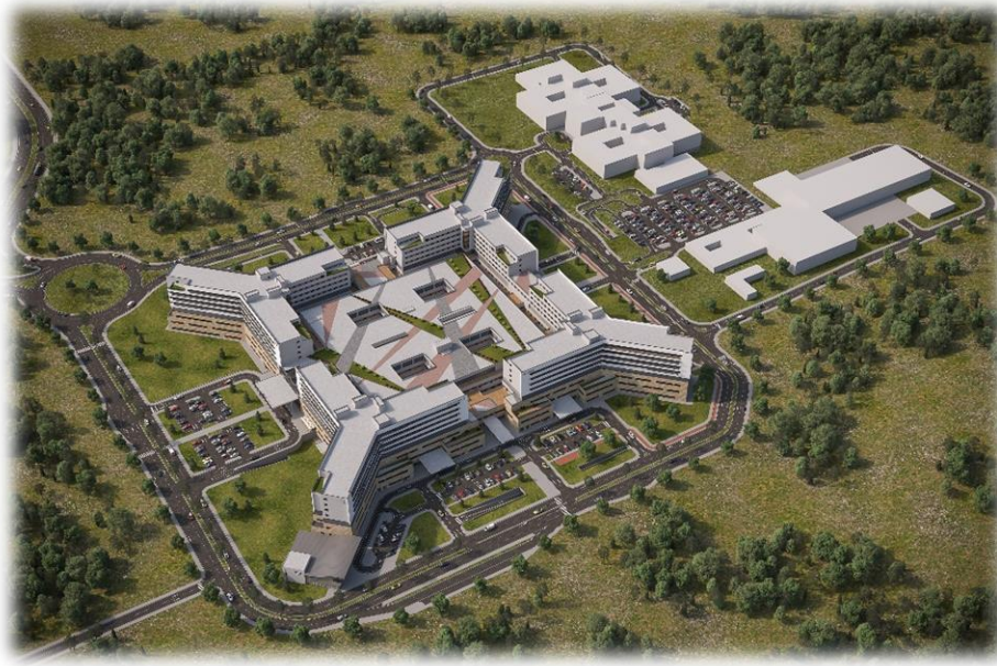
Şekil 1: Bursa Şehir Hastanesi
